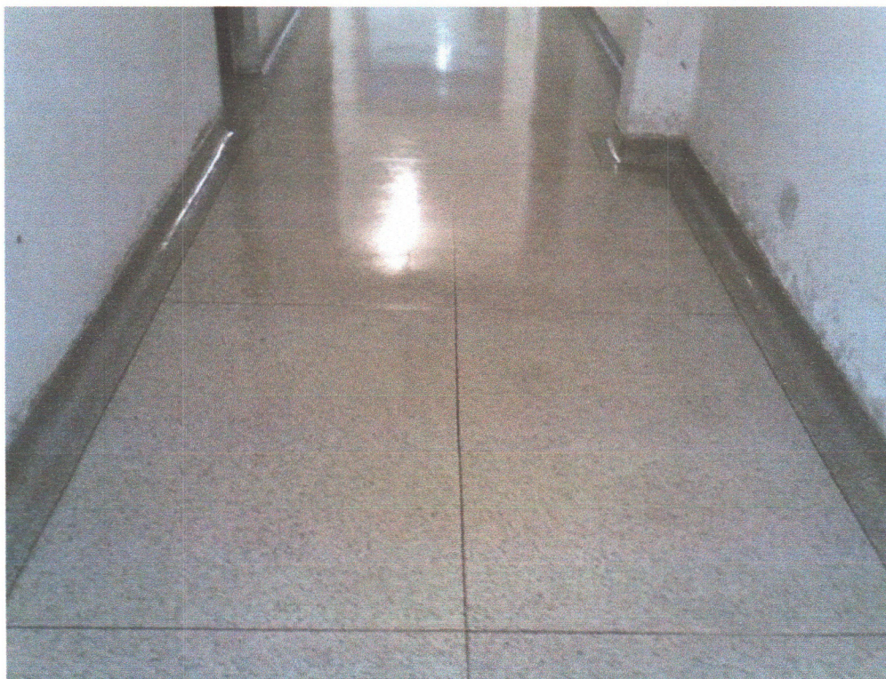
Figura 2: Piso em granilite com rodapé levemente curvado.
